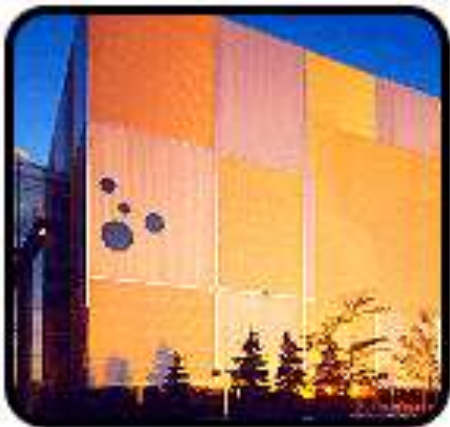
Здание цирка Du Soleil в Лас-Вегасе.
